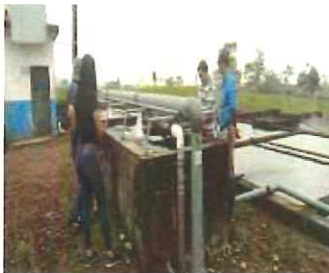
Junta Administradora de Agua Potable y Saneamiento "Julio Moreno"
