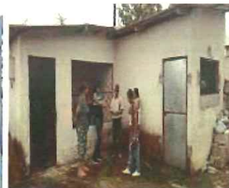
Junta Administradora de Agua Potable "Riobambeños de Chillimpe"
